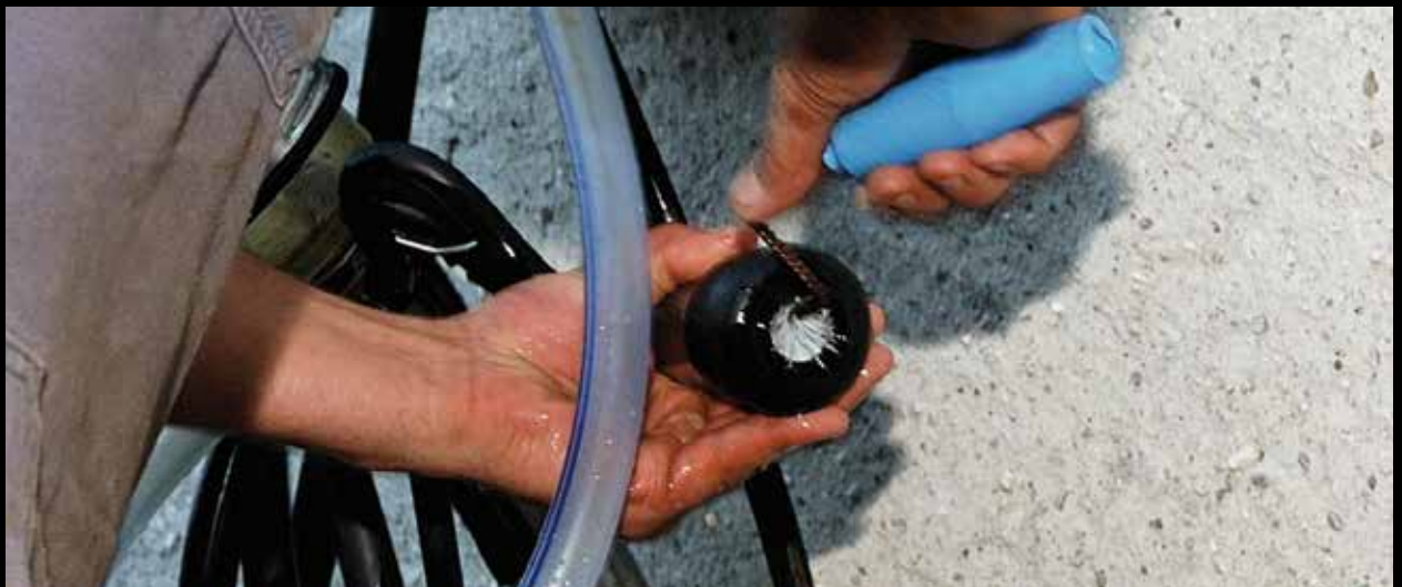
15. Nella pulizia della guaina fare attenzione a non provocare fessurazioni
